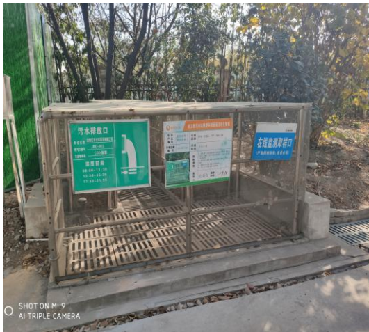
厂区污水排口
